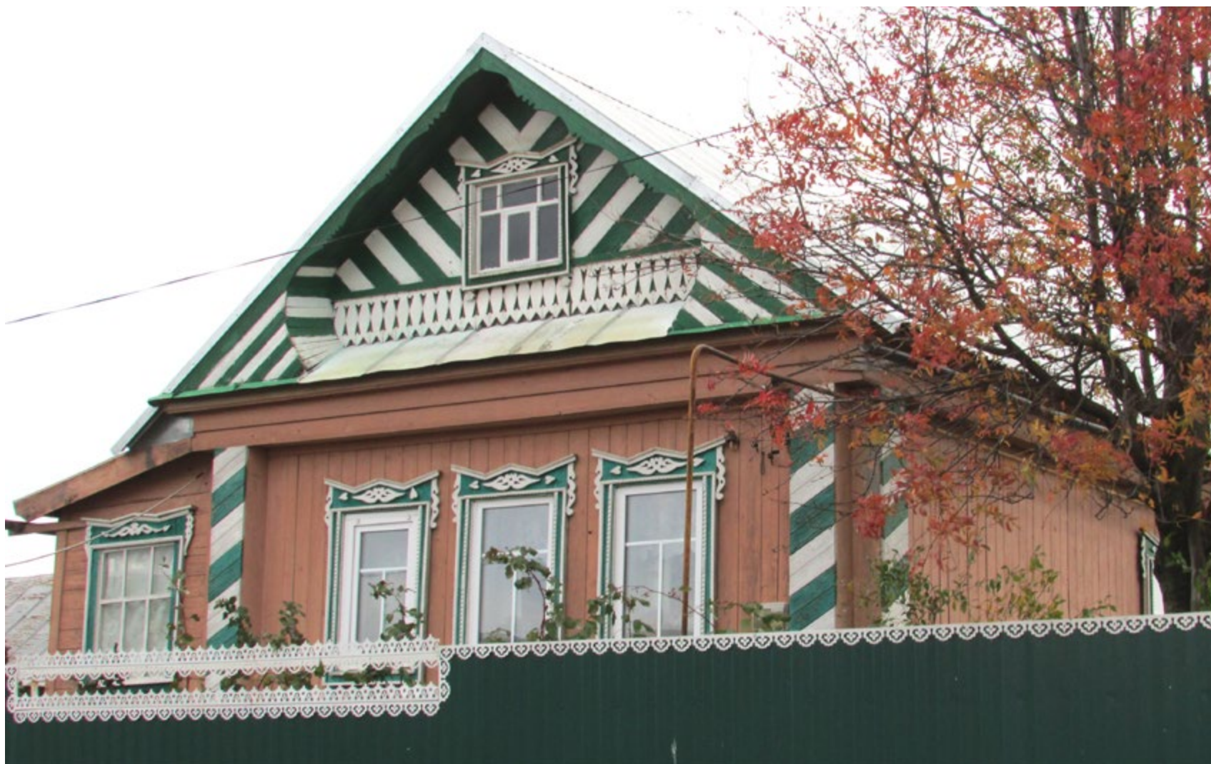
с. Нижняя Береске, ул. Чишмеле, д. 15
